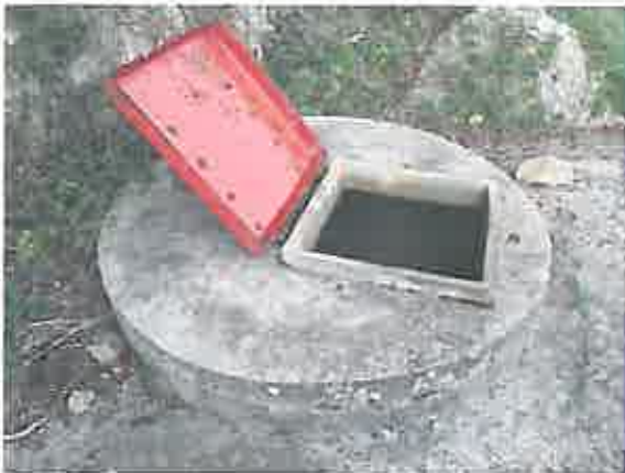
Puits d'accès au captage
