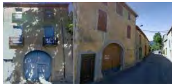
Habitation au-dessus de la cave pour le « faubourg » - rythme régulier des travées et ouvertures
