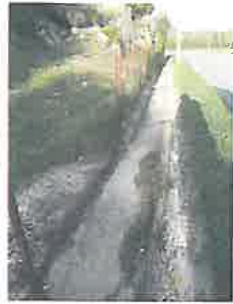
Caniveau bétonné longeant le captage et la route
