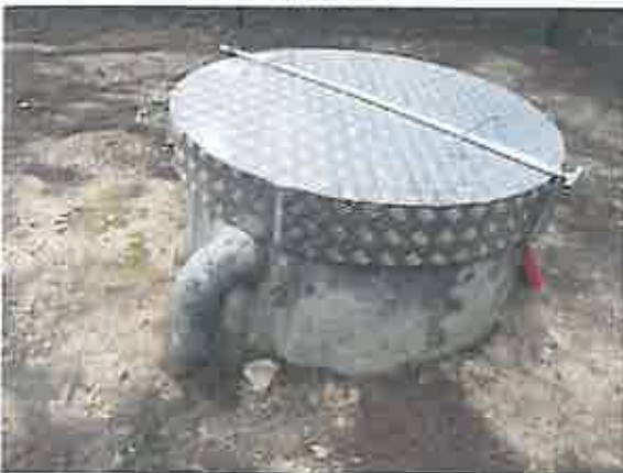
Tampon de visite du réservoir
