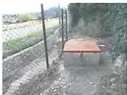
Accès – ancien captage
