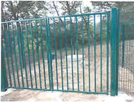
Accès au réservoir – clôture et tampon de visite
