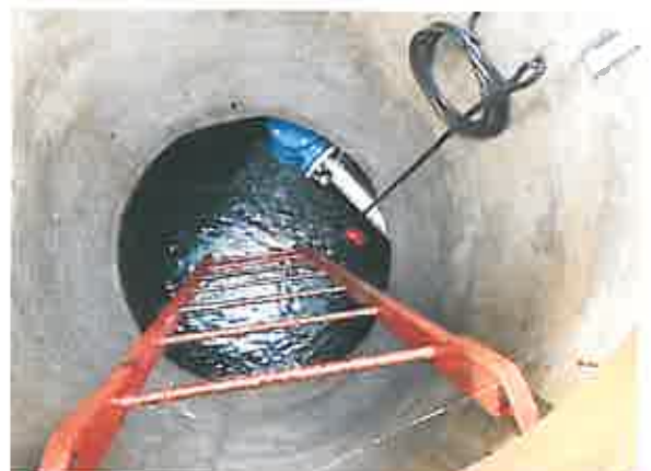
Intérieur du réservoir de 170 m 3
