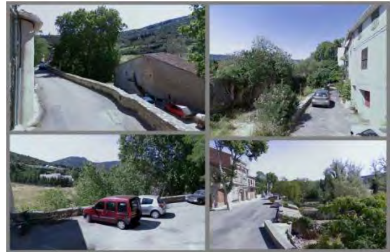
Protection contre les crues violentes du ruisseau de Feuilla avec le mur du « Barry » tout le long du front bâti au Sud
