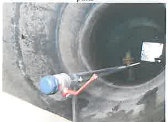
Intérieur de l'ouvrage
