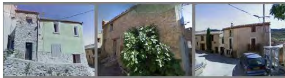
Rythme régulier des travées et ouvertures-Volumes plus réduit des habitations du centre ancien-granges attenantes
