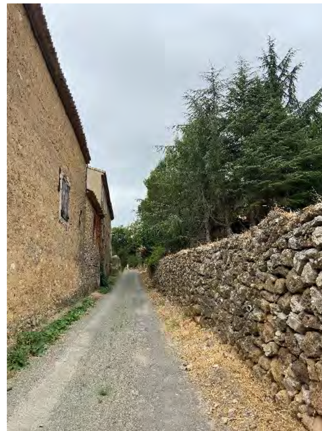
Mûrs de soutènement
